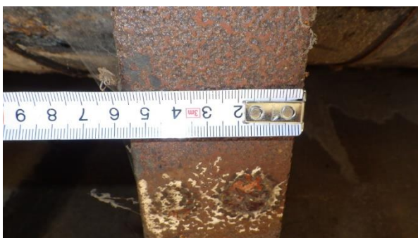
Foto P2.7.3 Měření šířky pásnice I profilu
