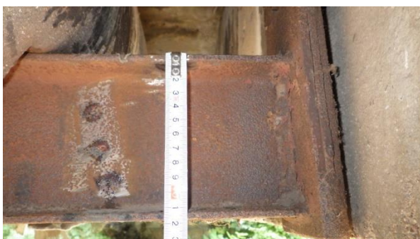
Foto P2.7.1 Měření výšky použitého I profilu
