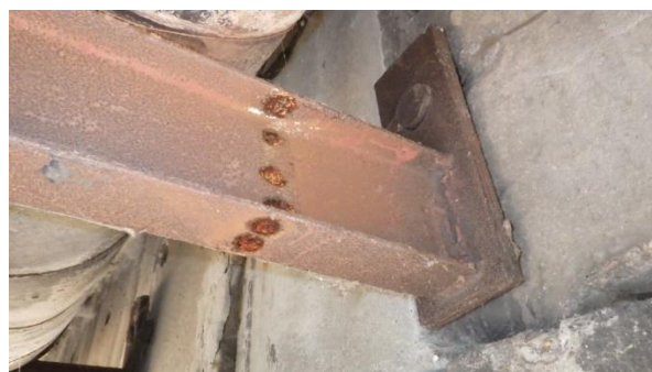
Foto P2.7.4 Pohled na I profil s tečkami po akustickém vazebním prostředku (vazelíně) v místě provedených ultrazvukových tloušťek na obou pásnicích i stojině prvku
