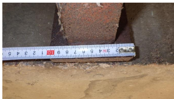
Foto P2.7.2 Měření šířky patní desky I profilu
